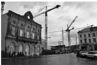
Aan het Luxemburgplein wordt druk gebouwd.
